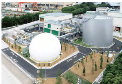
【左】食品のバイオ処理と再生可能エネルギーの発電を行う、食品リサイクル発電プラント。
