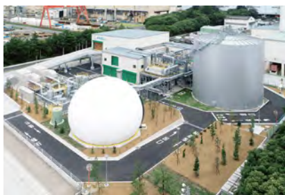
【左】食品のバイオ処理と再生可能エネルギーの発電を行う、食品リサイクル発電プラント。
